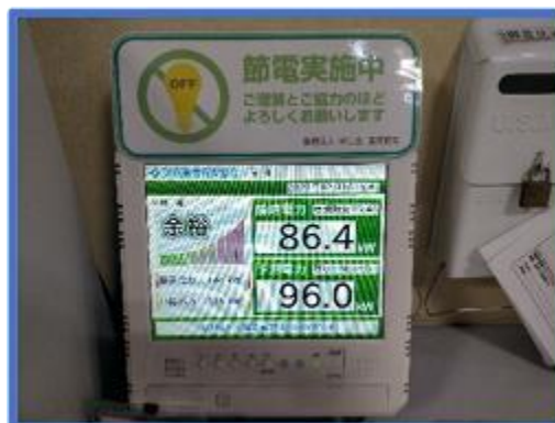
↑ 節電モニターの設置
