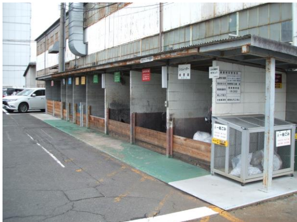
廃棄物置場での分別状況
