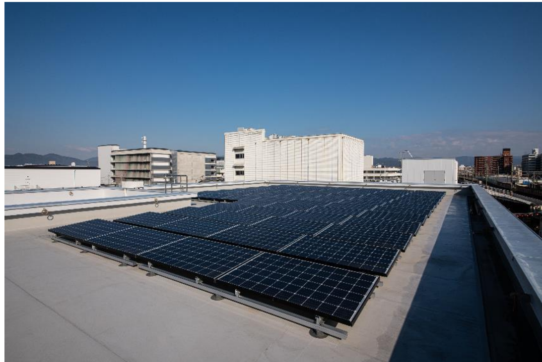
京都市中央卸売市場 新水産棟
