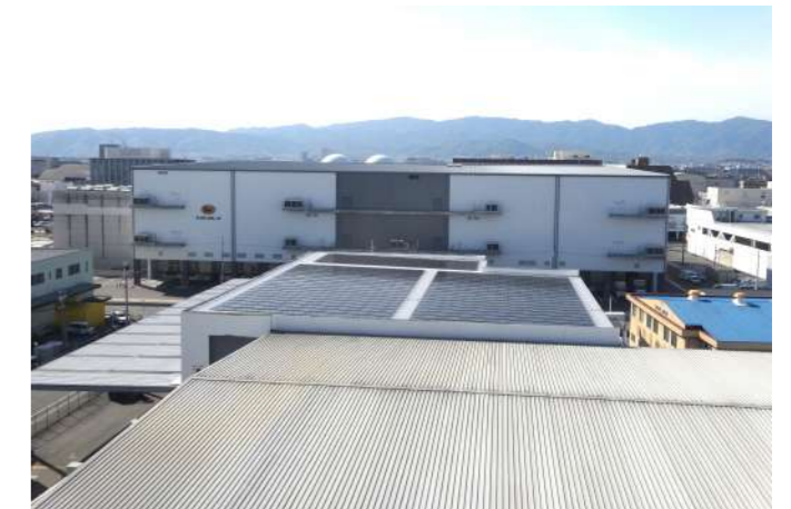
💡 太陽光発電設備
