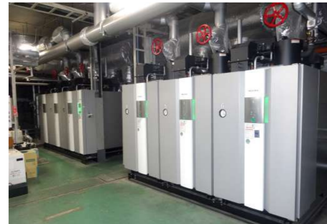
💡 高効率ボイラ
