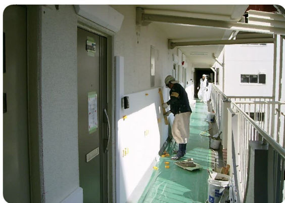
断熱材の貼付工事の様子
