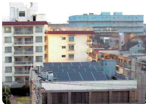
太陽光発電設備
