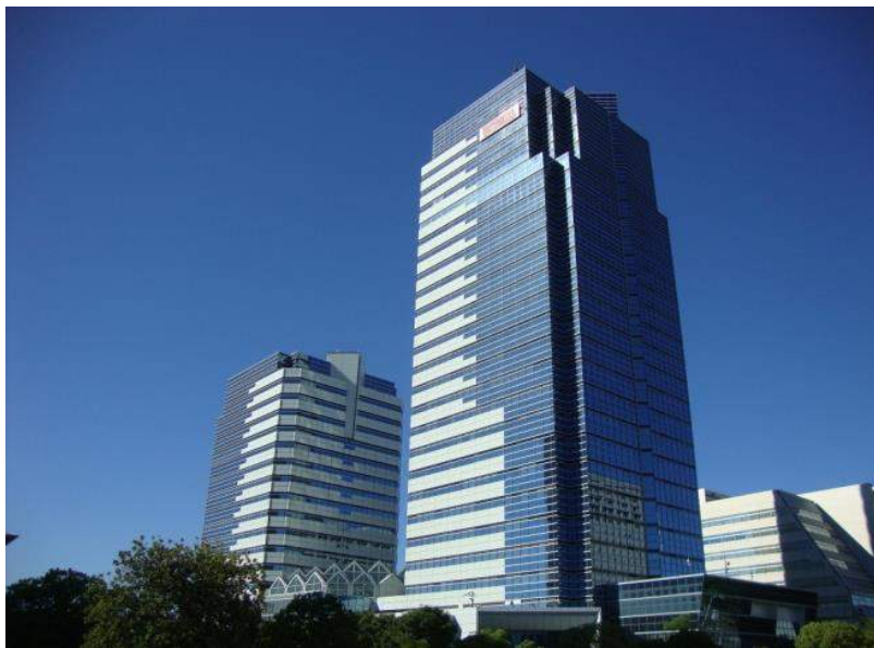
有明フロンティアビル
