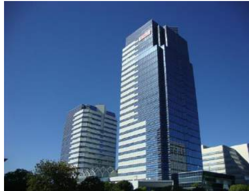
有明フロンティアビル
