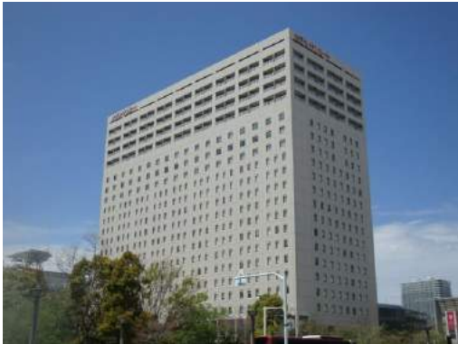
有明プライムビル
