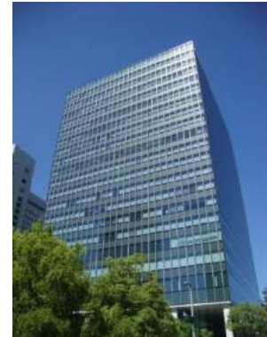
有明セントラルタワー
