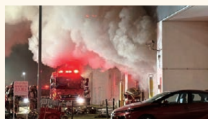
南部クリーンセンター火災被害状況 (令和8年1月)
