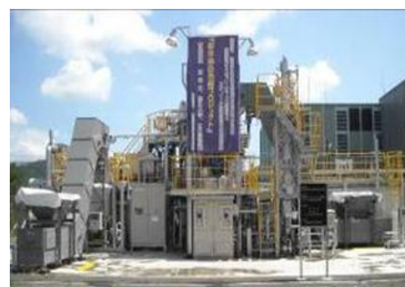
〈「都市油田」発掘プロジェクト実証プラント〉
