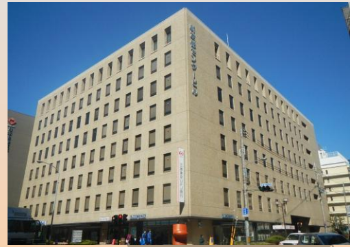
新京都センタービル
