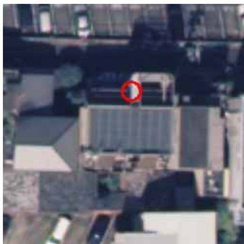
06ND6412-20 *2 上京区 弾正町 丸忠マンション
