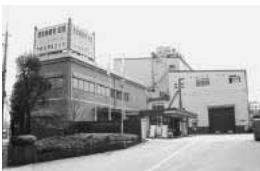
中間処理施設
