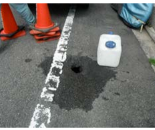
重大な事故につながる道路陥没
