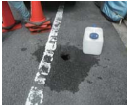
道路陥没補修の写真
