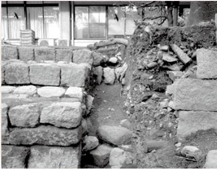
図2 北岸：間知石積護岸の下から旧階段検出（南から）
