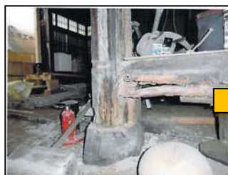
柱の劣化部分の修繕
