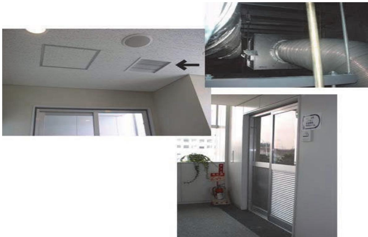
開放されていた出入り口にガラリ<sup>18</sup>のある扉をつけ、天井に排気口、天井裏に排気装置を増設して喫煙室からたばこの煙が漏れ出さないようにした。改善に要した費用は約 120 万円である。
