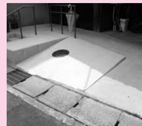
住宅の玄関をリフォームして造ったバリアフリーのスロープ
