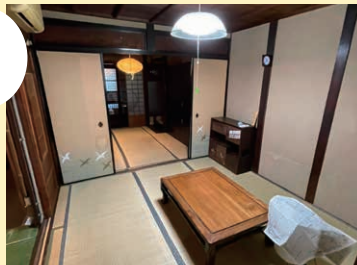
改修前の内部
