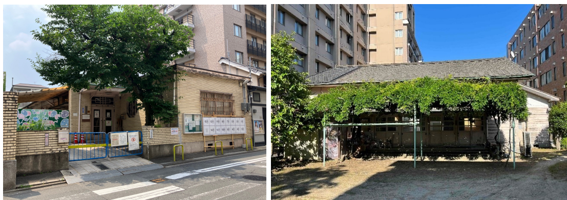
元京都市立明倫幼稚園（「こども本の森京都」に改修予定）
