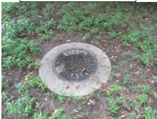
撮影方向：物件内（防火井戸）
