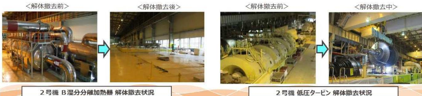
2号機 B湿分離加熱器 解体撤去状況
