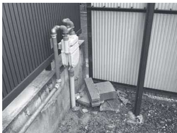
撮影方向：東隣家越境箇所（ガスメーター）
