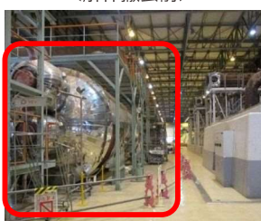
1号機 B湿分離加熱器 解体撤去状況
