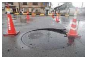
左京区北門前町 (下水管へ大雨が流入したことにより行き場失った空気がマンホールを押し上げ隆起した舗装(仁王門交差点))
