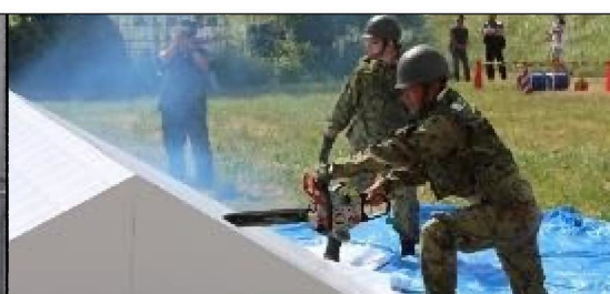
自衛隊によるチェーンソーを活用しての開口部作成
