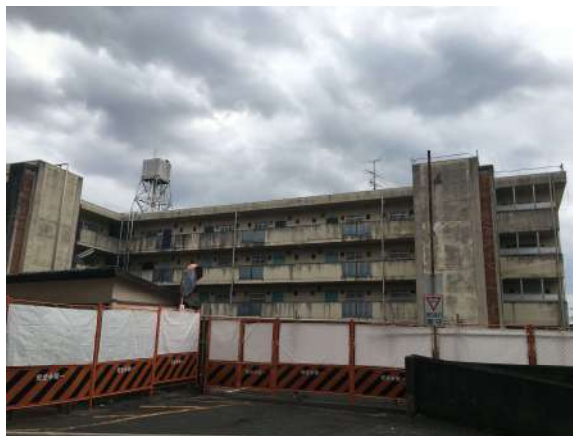
4号館 撮影方向：物件北から南向き
