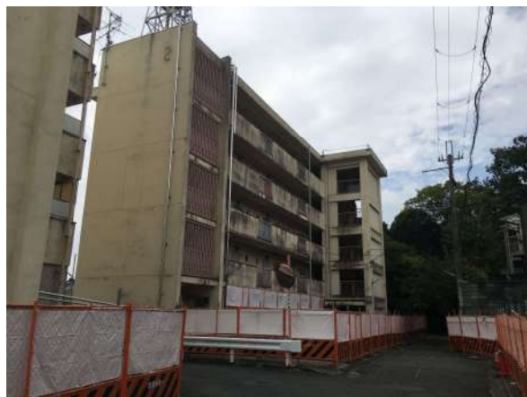
2号館 撮影方向：物件東から西向き
