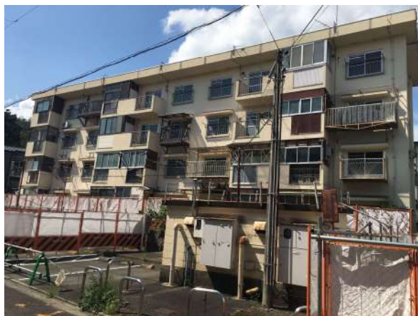
1号館 撮影方向：物件南から北向き
