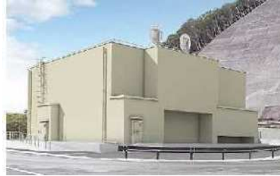
新緊急時対策所全景
