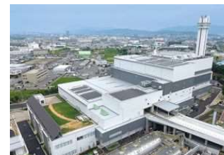
[南部クリーンセンター第二工場]
