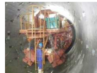
〔雨水幹線の整備〕
