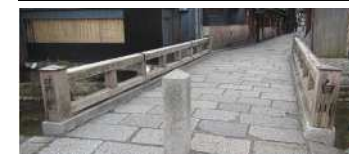
巽橋木製高欄の改修
