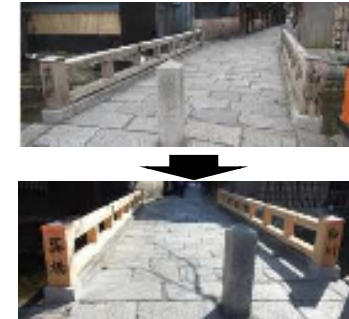
巽橋木製高欄の改修
