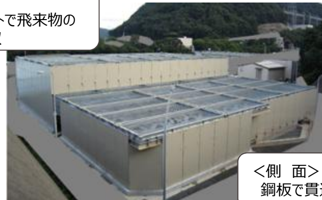
〔竜巻飛来物対策設備設置後〕
