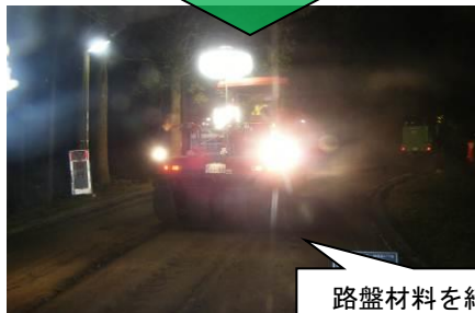
添加材料と路盤材料を攪拌
