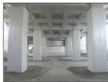
↑ 一部の橋脚を鋼板で補強しました。
