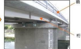
↑ 柵を取替え、桁を塗替えました。
