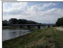
↑ 老朽化修繕等の設計をしています。
