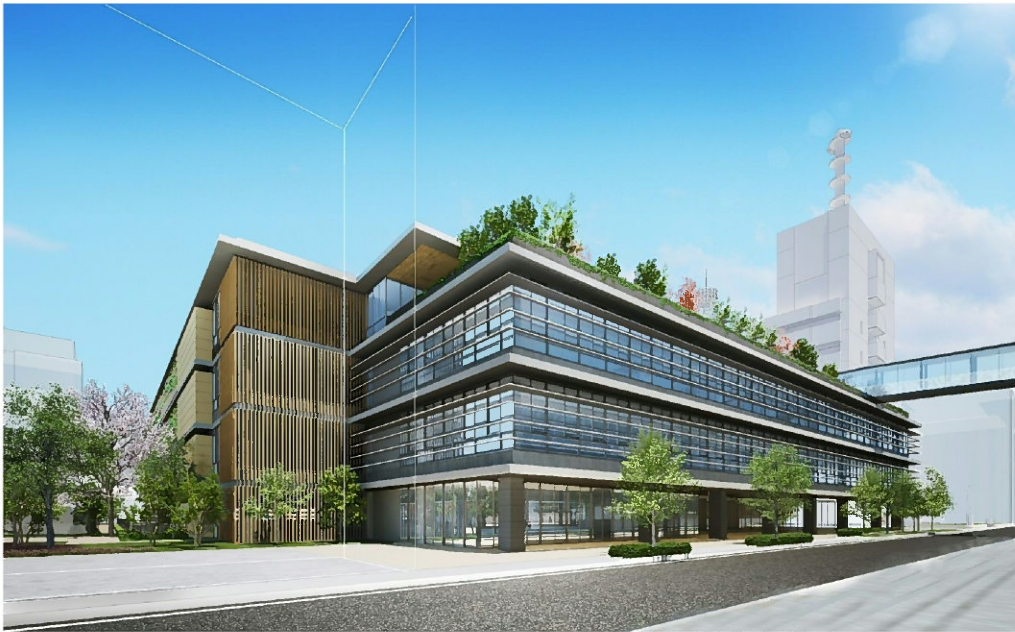
分庁舎外観 南西より
