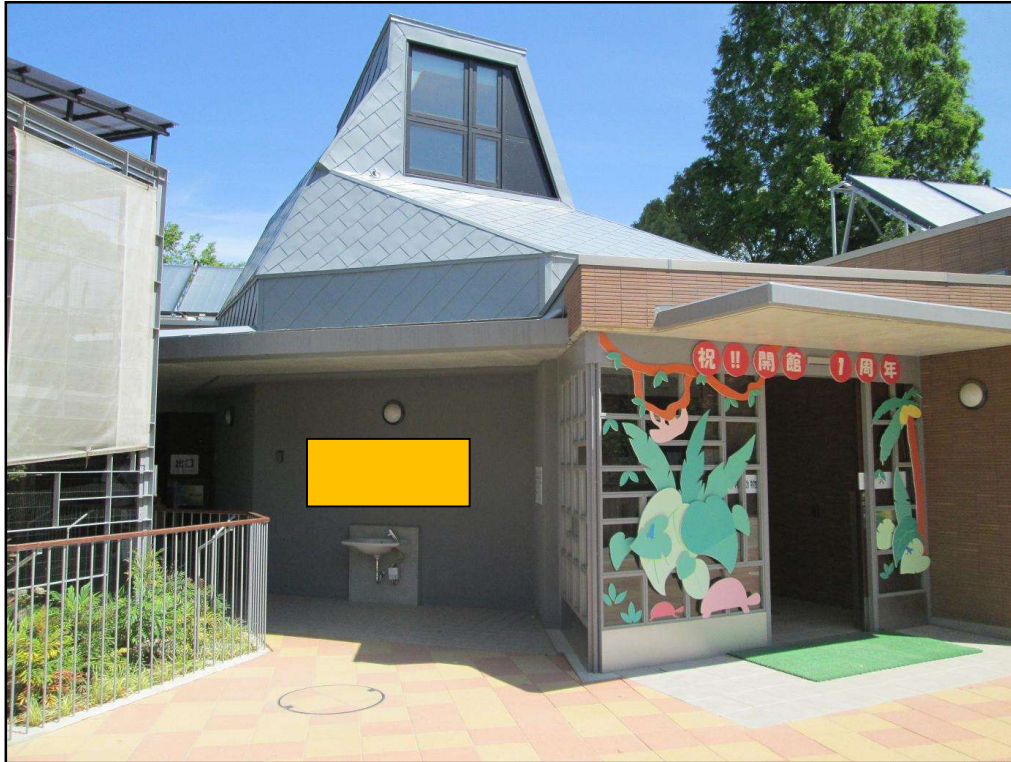
①ひかり・みず・みどりの熱帯動物館（出口付近）
