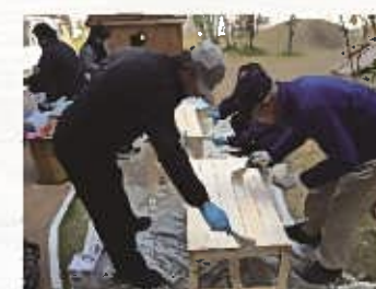
ベンチの防錆剤塗り作業
