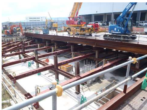
天井部の施工の様子(令和5年6月撮影)
