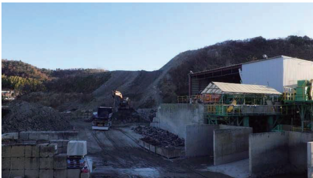
(令和5年7月17日の撤去の様子)
