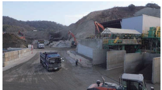
(令和6年1月13日の撤去の様子)
