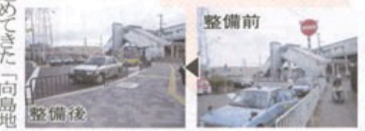
整備前 整備後
