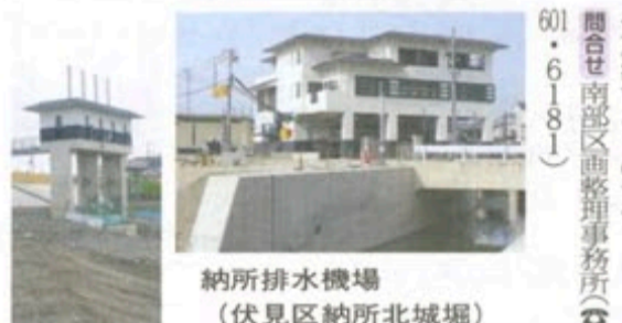
納所排水機場 (伏見区納所北城堀)
