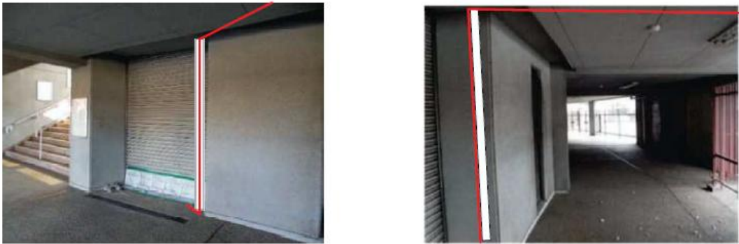
野球場1Fシャッター内より光回線取り出し 仮設ポールを利用して立ち上げ通路を渡す
