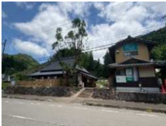
改修古民家コミュニティ施設
