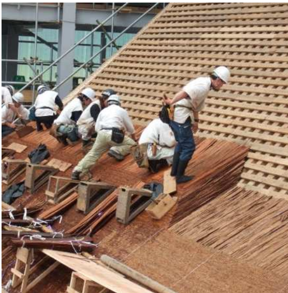
檜皮を竹釘で留めながら葺き上げていく様子
