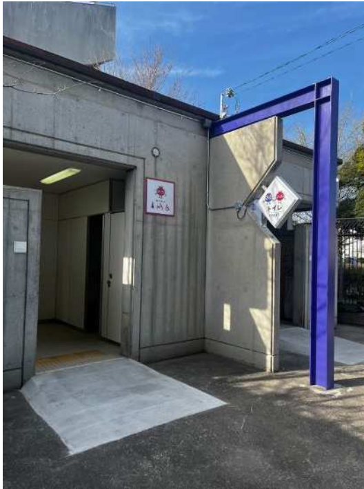
改修後のトイレの様子
