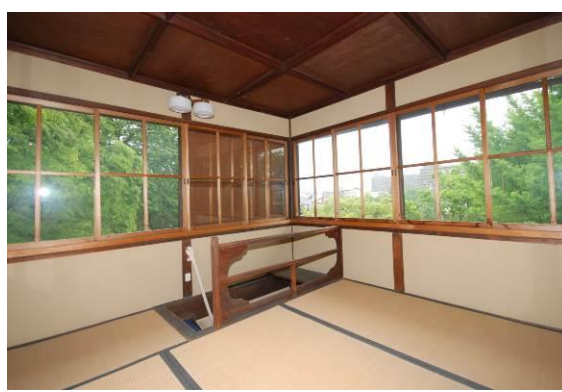
〔写真 1-20〕 主屋3階 望楼 階段及び建具
