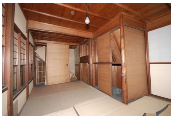
〔写真 1-17〕 主屋中3階 和室
