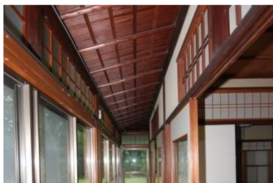
〔写真 1-6〕 主屋 1 階 座敷縁廊下 化粧屋根裏の様子
