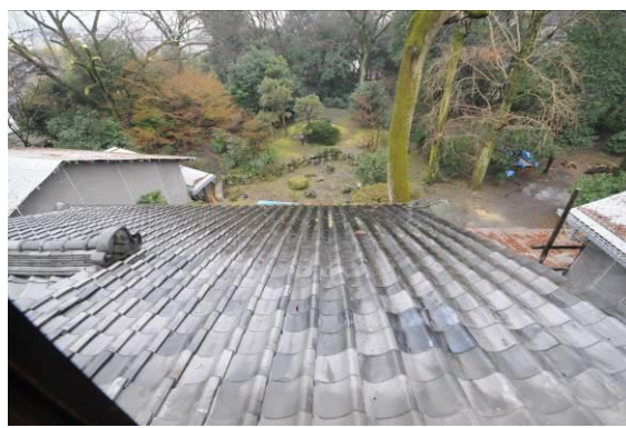
〔写真 1-22〕 主屋3階 望楼南窓より見下ろす
