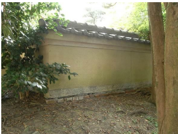
入口付近の築地塀内側の状況
