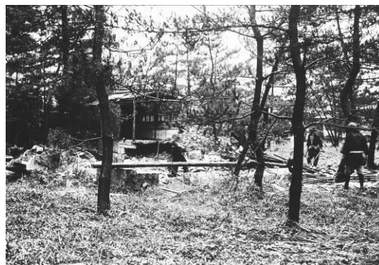
〔写真 1-3〕物見（敷地南端）の毀損状況（「昭和10年 下鴨別邸水害状況写真（付別邸図面）」写1404）
