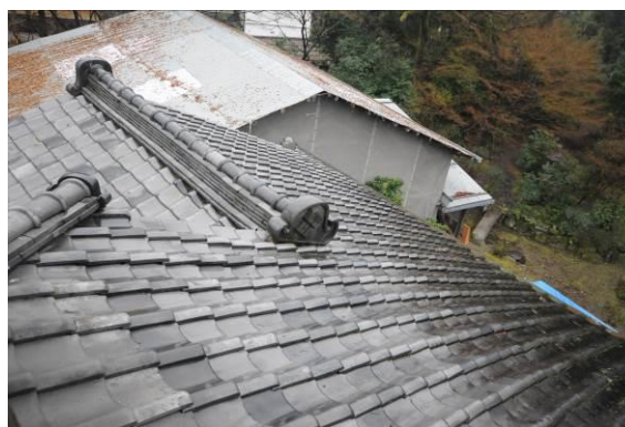
〔写真 1-21〕 主屋3階 望楼南窓より見下ろす
