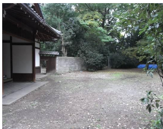
後補ブロック塀
