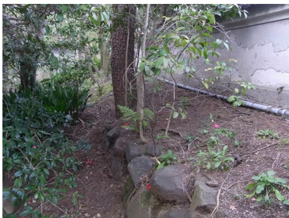
〔写真 1-37〕 東側土塀（茶室東側）
