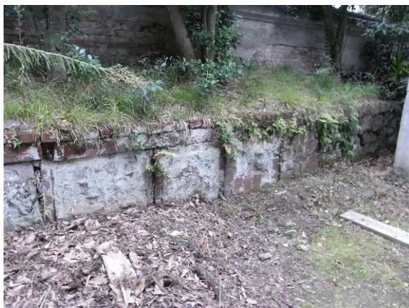
ポンプ室周辺 煉瓦塀基底部
