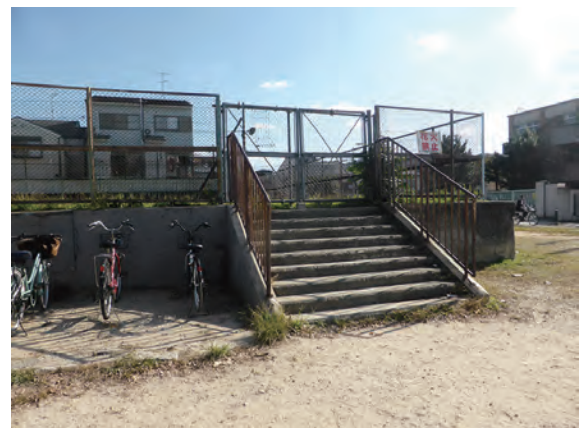
図3-12 プール跡の構造物
