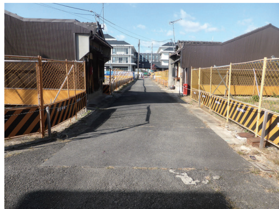
図3-14 塔跡周辺の民家及び道路
