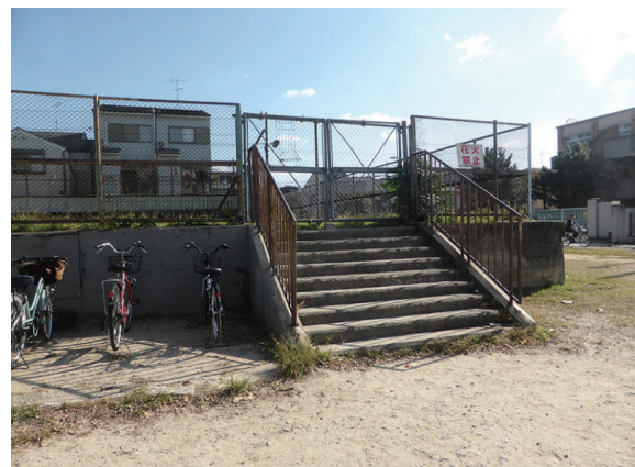
図3-12 プール跡の構造物
