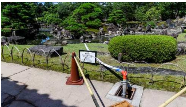
⑤消火栓にホースをセット
