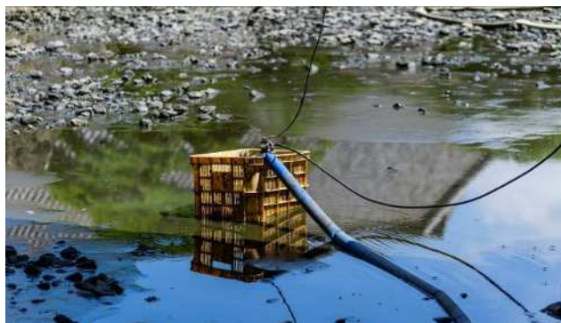
②水が抜き切らない場所は水中ポンプを使って水を排出
