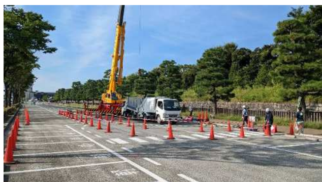
③駐車場内設営（歩行者迂回路設置）
