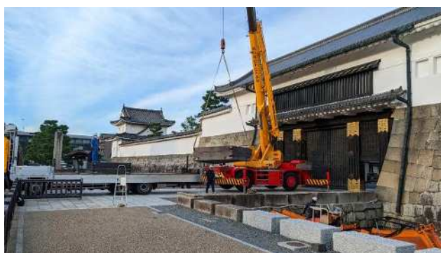
②台船着水作業
