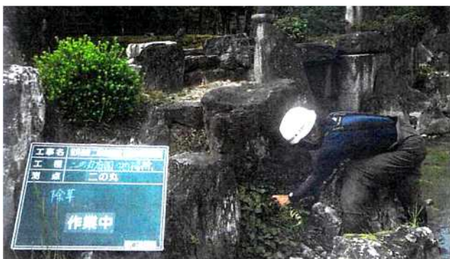
⑦護岸の雑草を除去
