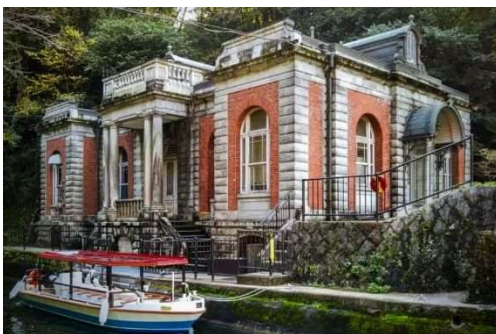
旧御所水道ポンプ室
