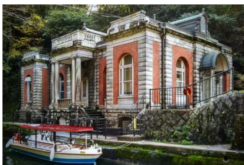
旧御所水道ポンプ室
