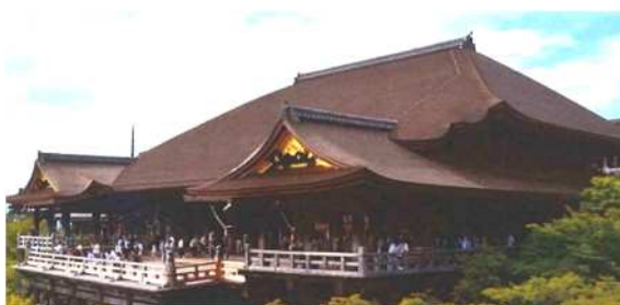
檜皮葺の清水寺本堂の屋根
