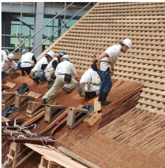
檜皮を竹釘で留めながら葺き上げていく
